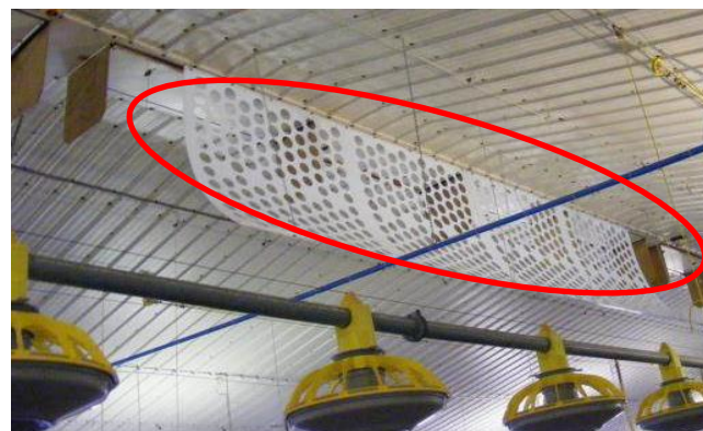
In de nok geplaatste geperforeerde PE 'Air Catchers'
