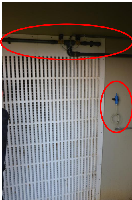
Magneetventielen sproeilijn en voeler
