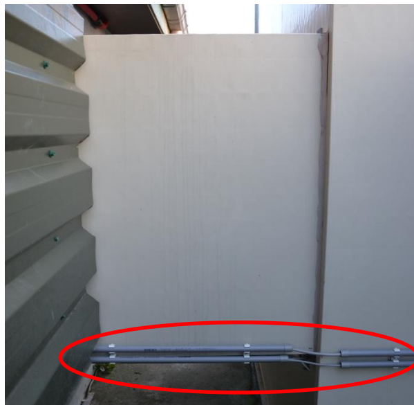
Bekabeling van wisselaar naar stal langs kanaal
